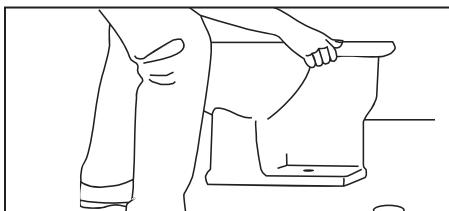
5. Posez délicatement la cuvette sur la bride, en vous assurant que les boulons de la bride traversent les orifices à boulon de la toilette.
