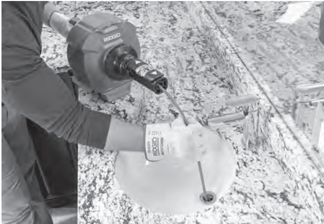
図 14 - 手動でのケーブルの送り出し
