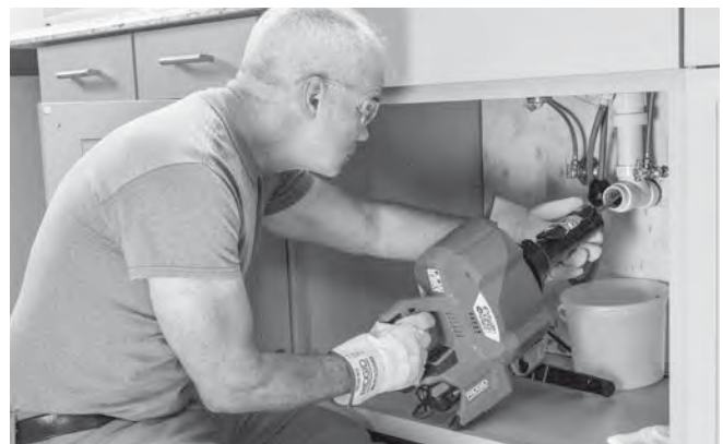
Slika 13 – Podajanje spirale skozi enoto AUTOFEED
