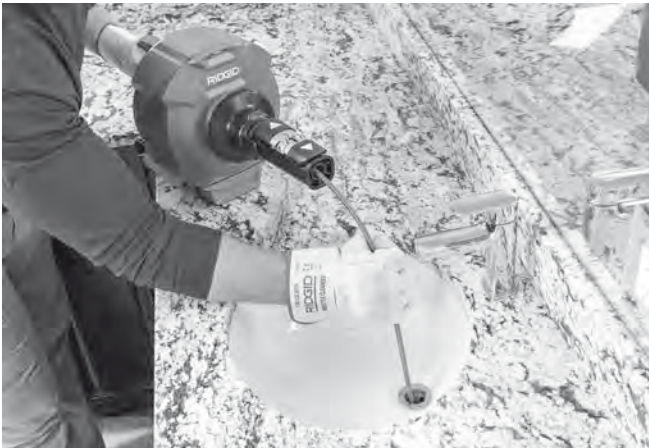
14. ábra - Kábel kézi előtolása
