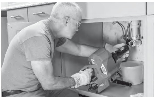
Фигура 13 – Подаване на кабел с AUTOFEED блока
