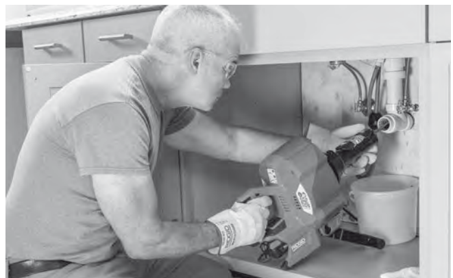
Obrázek 13 – Podávání kabelu pomocí jednotky AUTOPOSUVU
