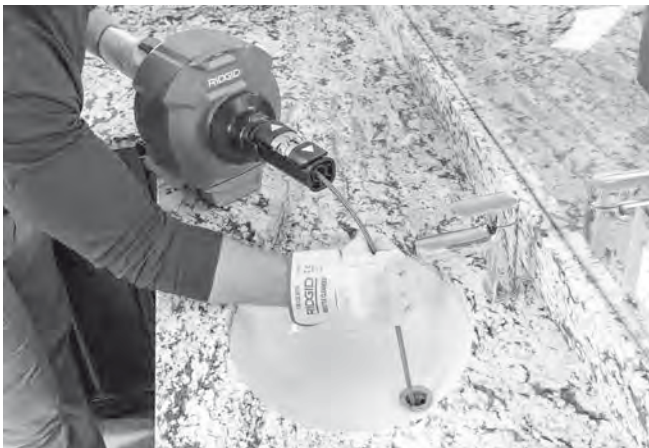
Figura 14 – Avansarea manuală a cablului
