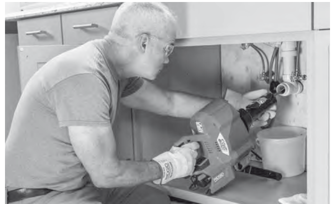
Figura 13 – Avansarea cablului cu unitatea AUTOFEED
