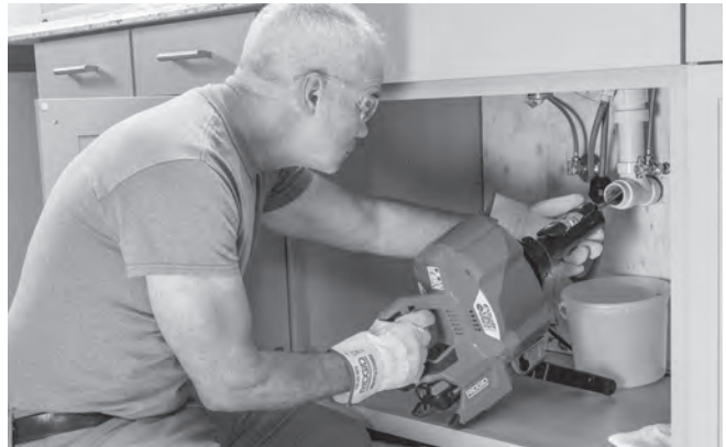
그림 13 - AUTOFEED 장치가 있는 피딩 케이블
