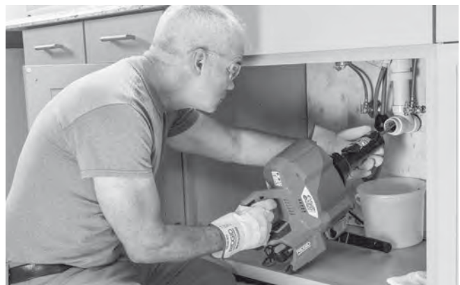
Figur 13 – Mating av kabel med AUTOFEED-enhet
