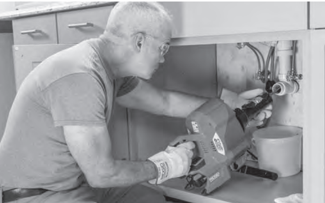
Figura 13 – Alimentación del cable con la unidad AUTOFEED
