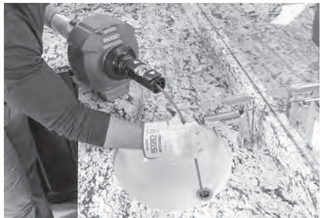
Abbildung 14 – Manuelles Vorschieben der Spirale
