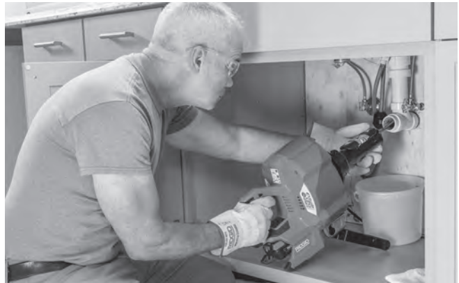
图 13 – 使用 AUTOFEED 自动进给单元推进钢索
