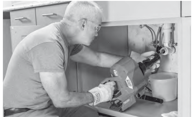
Slika 13 – Uvlačenje sajle kroz s jedinicom AUTOFEED
