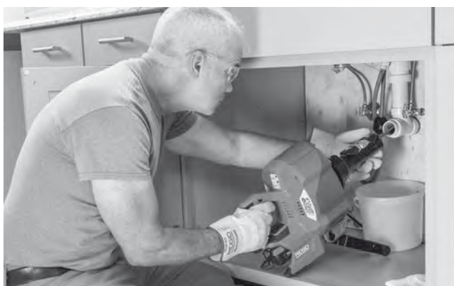
13. ábra - A kábel előtolása az AUTOFEED egységgel
