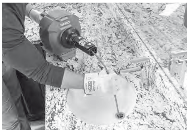
Obrázek 14 – Ruční posouvání kabelu
