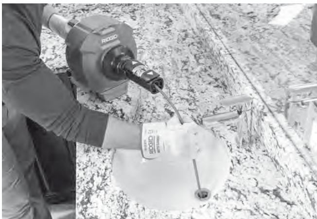
Afbeelding 14 – Manueel invoeren van de veer
