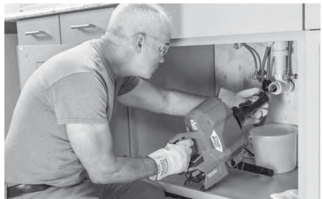
Εικόνα 13 – Πρώθηση του σπιράλ με τη μονάδα AUTOFEED
