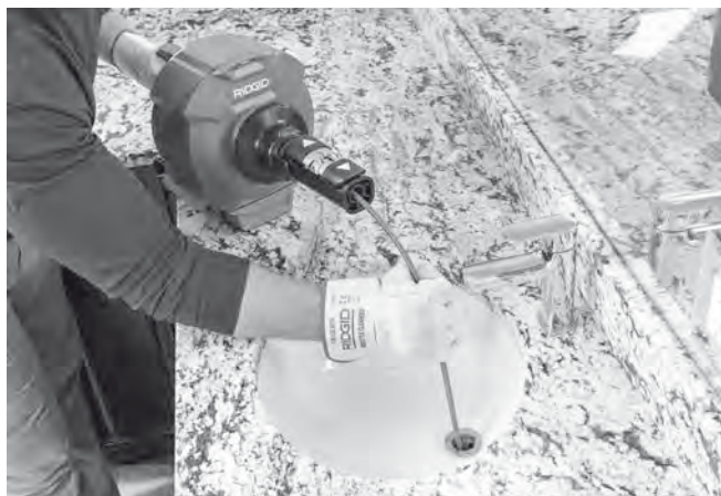
Рисунок 14 – Подача троса вручную
