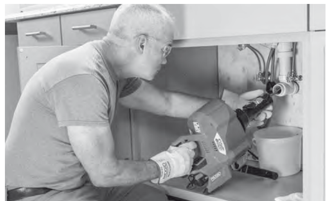
Figur 13 – Fremføring af spiral med AUTOFEED-enheden
