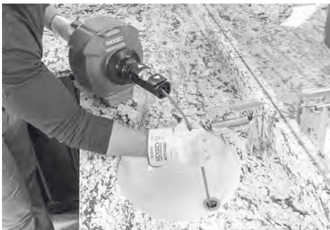
Figura 14 - Inserimento manuale del cavo
