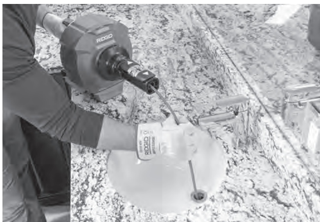
Figure 14 – Avancement manuel du câble
