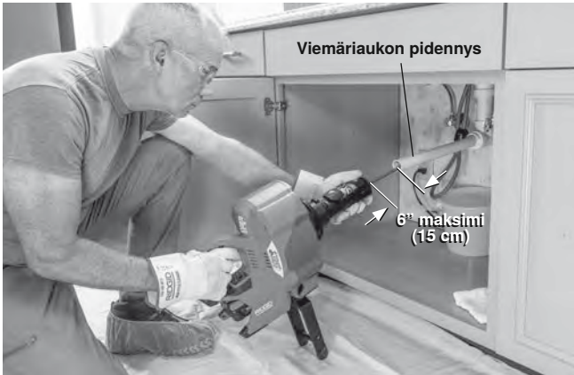
Kuva 6 - Esimerkki viemäriaukon pidentämisestä yli 6" (15 cm) päähän AUTOFEED -yksiköstä
