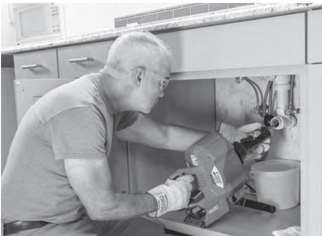
Abbildung 13 – Vorwärtsschieben der Spirale mit AUTOFEED
