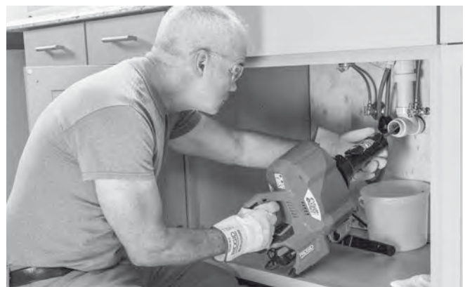
Slika 13 – Sprovođenje sajle sa AUTOFEED jedinicom
