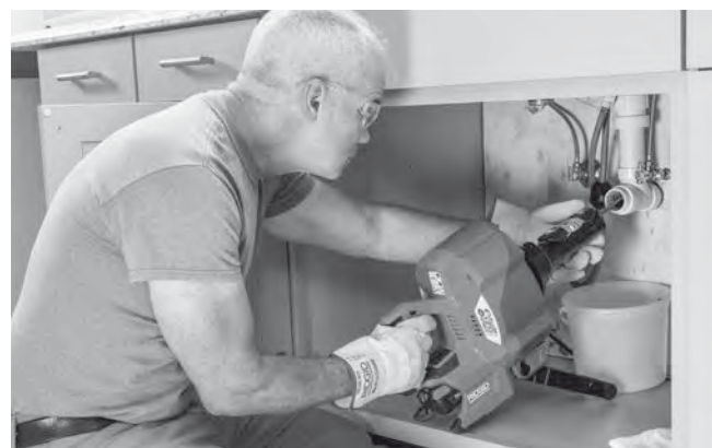
Figura 13 - Inserimento del cavo con l'unità AUTOFEED
