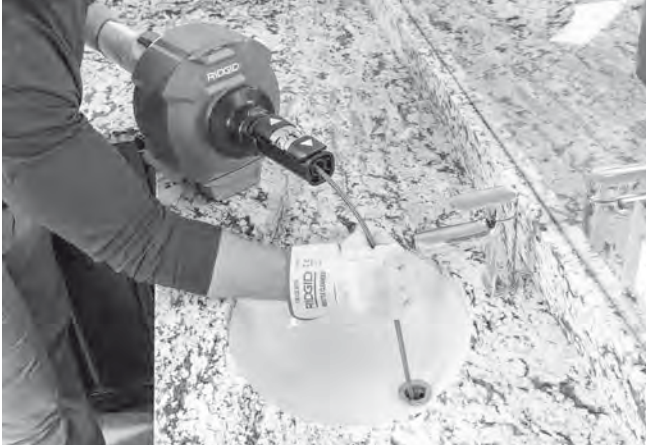
Şekil 14 – Kablonun Manuel Beslenmesi
