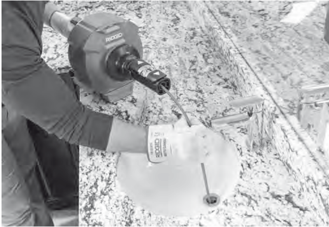
Фигура 14 – Ръчно подаване на кабел
