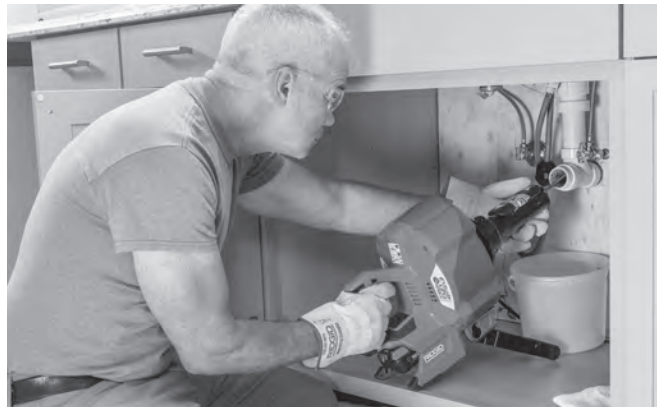
図 13 - AUTOFEED ユニットでのケーブルの送り出し
