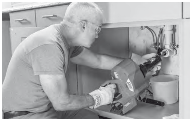
Figura 13 – Empurrar o cabo com unidade AUTOFEED
