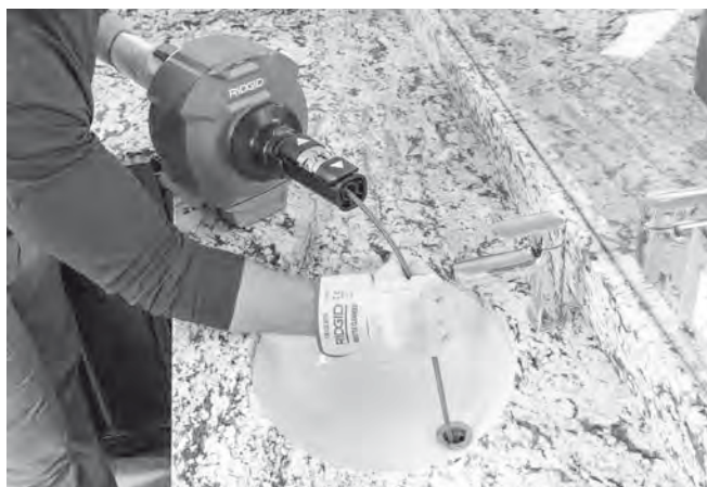
Slika 14 – Ručno uvlačenje sajle
