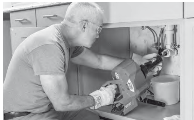
Рисунок 13 – Подача спирали с помощью устройства автоподдачи
