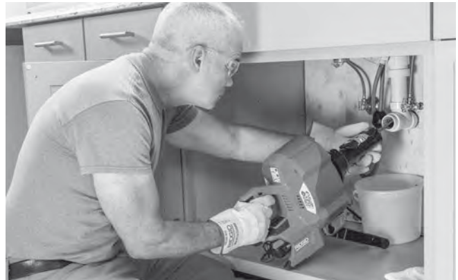
Kuva 13 - Jousen syöttäminen AUTOFEED-yksiköllä
