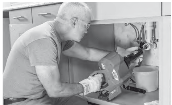
Afbeelding 13 – De veer met de AUTOFEED-eenheid invoeren
