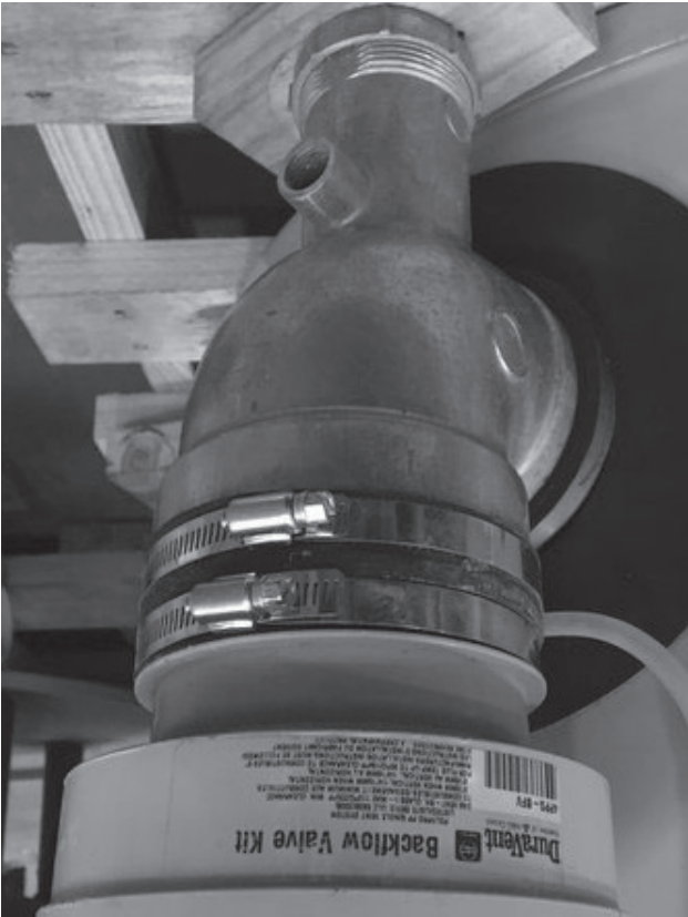
Figure 13. ADAPTATEUR ÉVENT DE SORTIE AU POLYPROPYLENE
