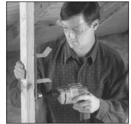
Fixer le support de montage (MB).
