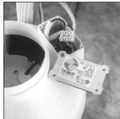
Câblage Romex - Vue de dessus.
