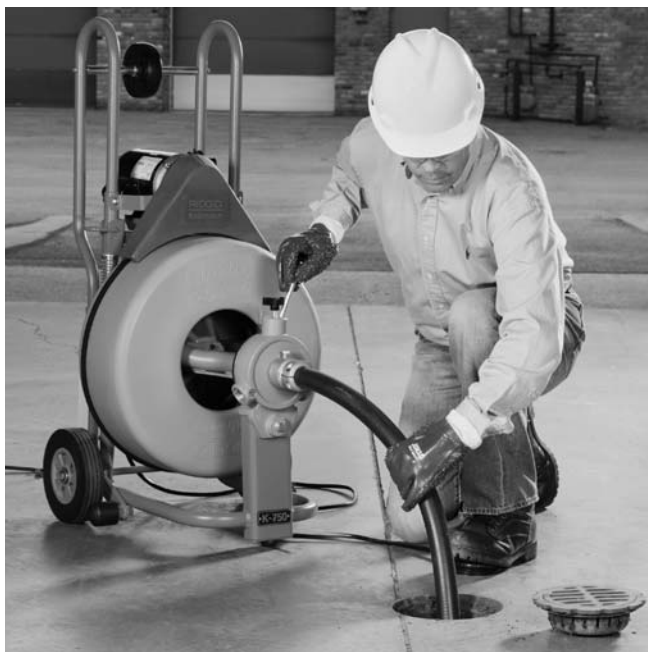
Figura 15 – Empleo de una limpiadora con manguera-guía delantera
