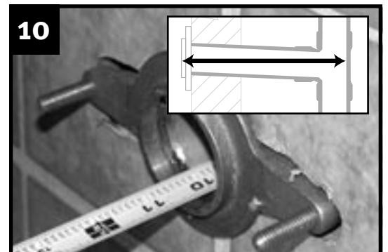
Trouver la profondeur du tuyau de renvoi en relevant la distance entre le dos du té sanitaire (ou coude) et le rebord avant de la bride de laiton existante.
