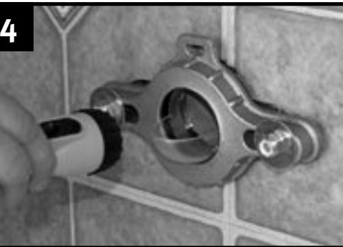
Trancher le calfatage existant et enlever la cuvette à l'aide d'un maillet et d'un couteau à mastic. Démonter les supports, gratter le calfatage et nettoyer le mur.
