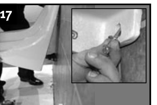
Accrocher la cuvette en insérant le tuyau de renvoi dans le manchon. Monter les vis du bas de la cuvette et leurs rondelles. Serrer les noix de la bride et la vis de la bande de serrage.
