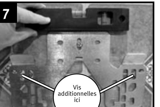
Mettre le support à niveau, marquer, percer et installer deux ancrages additionnels ainsi que les vis. Les vis ne sont pas nécessaires s'il y a des tiges de montage.
