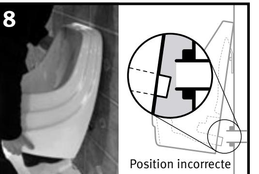
Accrocher la cuvette au mur, aligner le tuyau de sortie et puis enlever la cuvette et ajuster le support tel que requis.
