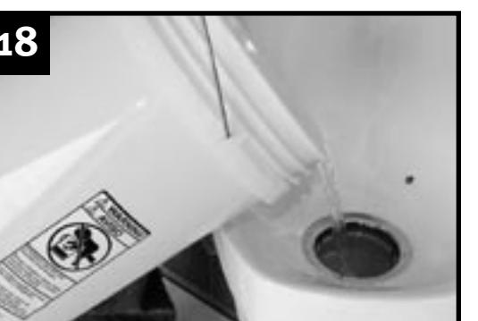
Verser rapidement dans le boîtier 5 gallons (18 litres) d'eau pour vérifier l'écoulement, l'étanchéité et s'assurer qu'il ne reste aucun liquide au fond du boîtier.
