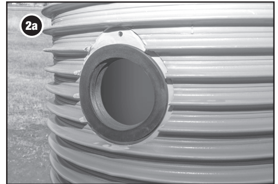
Install the grommet.
