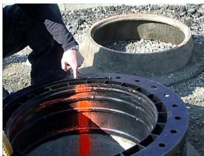
**5.** Cuando el conjunto esté instalado y tenga la altura y declive deseados, marque toda la pila con una línea vertical de pintura en lata. Una vez hecha la línea, desarme el conjunto.
