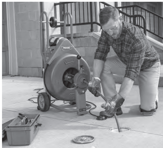
Figure 12 – Position de travail pour l'avancement manuel du câble
