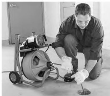
Figure 13 – En position de travail, avancement manuel du câble
