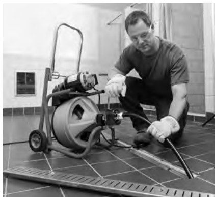
Figura 16 – Uso de la máquina con manguera-guía
