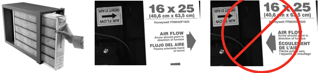
Fig. 18: cerciórese de que las flechas del filtro estén orientadas en la misma dirección que la flecha en el módulo de mejoramiento. Esto deberá estar en la misma dirección del flujo de aire.
