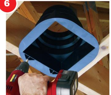
Si des fourrures sont utilisées, fixez la boîte à la solive en vissant à travers les ouvertures de dégagement prévues dans la bride. Si la fourrure n'est pas utilisée, les vis peuvent être fixées n'importe où à travers la bride ou la paroi latérale.
