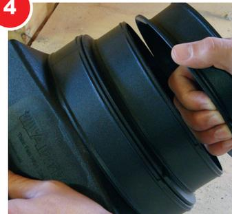
Saisissez la (les) section(s) de collier inutile(s) derrière la fente de séparation et tirez fermement.
