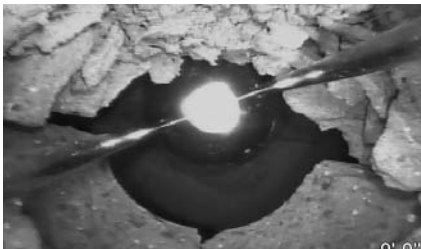
Figure 13 – Forage transversal typique dans conduite d'évacuation
