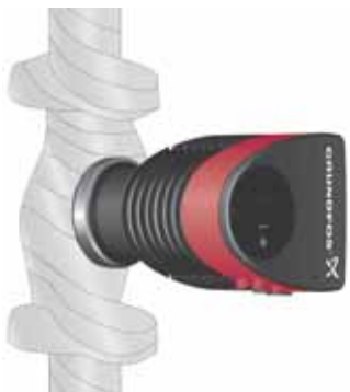
Fig. 13 Aislamiento de la carcasa de la bomba y las tuberías
