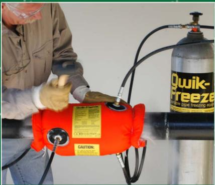
**A FREEZE IS MADE UPSTREAM FROM THE LOCATION OF A NEEDED REPAIR. THE DOWNSTREAM IS THEN DRAINED AND THE REPAIR COMPLETED**
