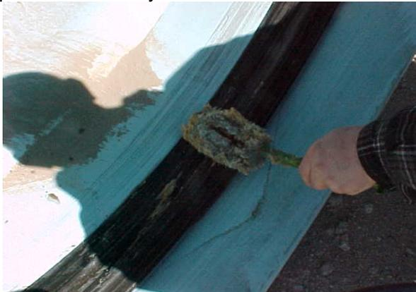
Photo 8 (lubricate gasket)
