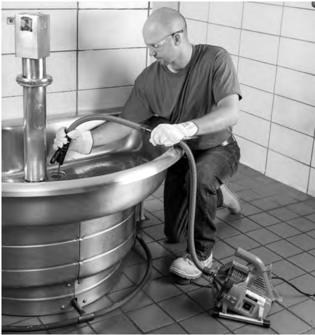
Figura 11 – Recuperación del cable
