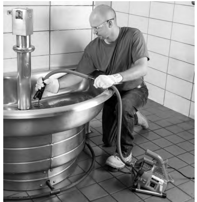
Figure 11 – Récupération du câble
