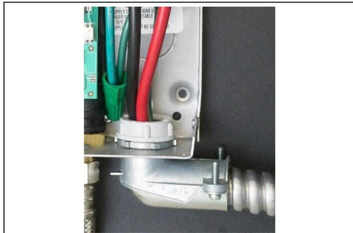
Les câbles d'alimentation doivent être fixés aux connecteurs L1 et L2 ou L et N sur le bornier ou le relais. Le fil de terre doit être fixé au connecteur de mise à la terre (GND) du bloc ou au fil de terre vert à l'aide de l'écrou fourni.
