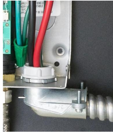
Los cables de alimentación deben fijarse a los conectores L1 y L2 o L y N del bloque de terminales o relé. El cable a tierra debe fijarse al conector GND que está en el bloque o al cable de tierra verde con la tuerca provista.
