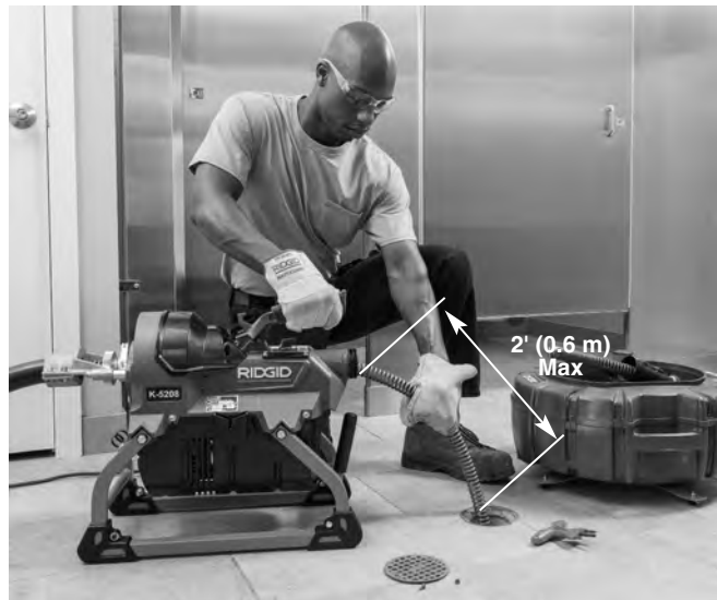
Figura 9 – El operario en posición de trabajo
