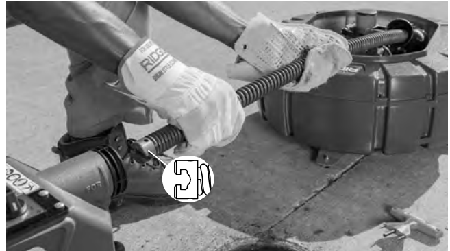
Figura 7 – Introducción del cable por el frente de la máquina
