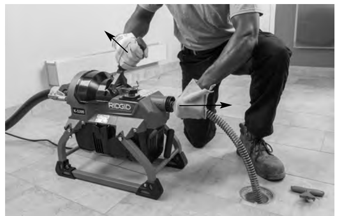
Figura 11 B – El embrague se ha soltado, el cable no está girando y el operario está jalando el cable para extraerlo de la máquina
