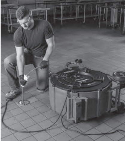
Figura 9 – Aplicación de lubricante sobre la vaina del cable
