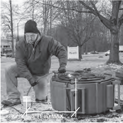
Figura 8 – El operario en posición correcta para trabajar
